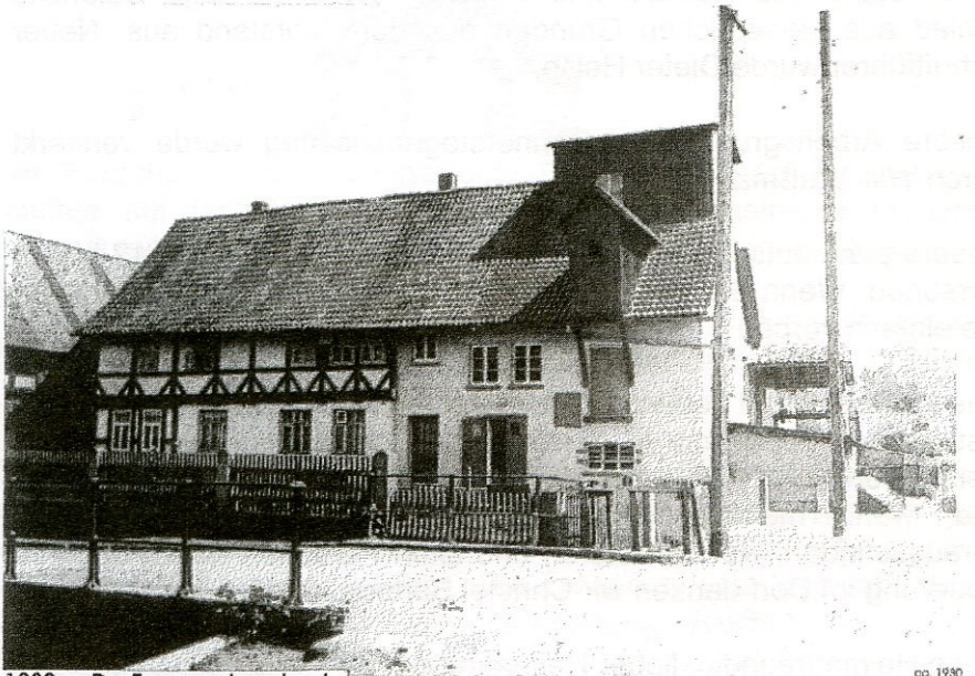
1930 Der Turm wurde gebaut
